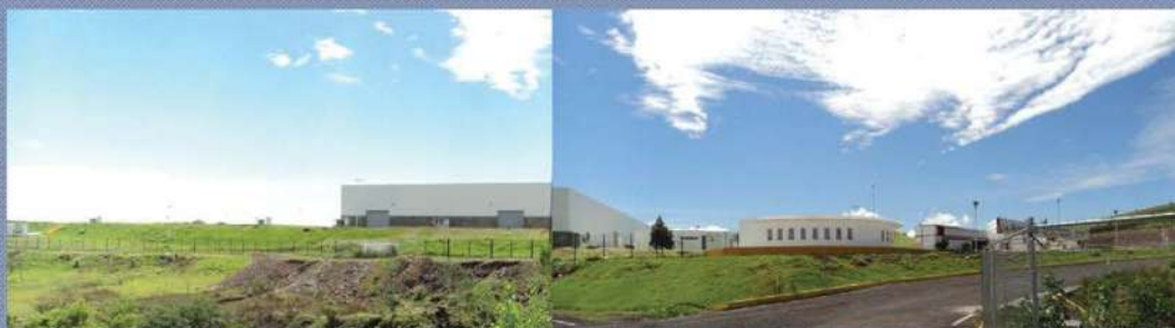
Fig. 52. Fotografía panorámica del acceso al recinto ferial.
