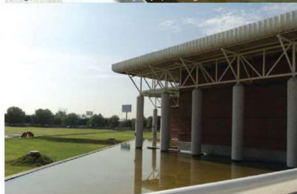
Fig. 71. Parte de la fachada principal y espejo de agua.
