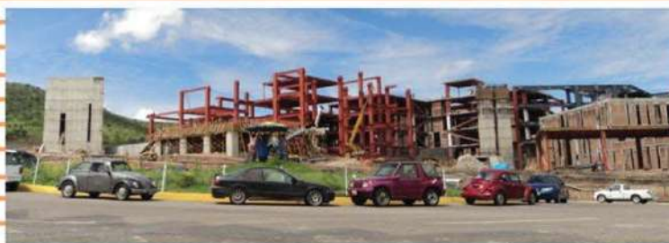
Fig. 54. HGR en construcción.
