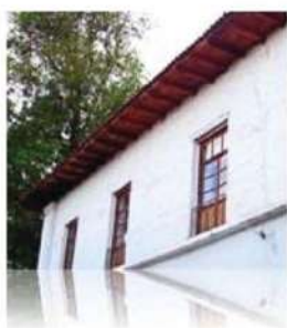
Fig. 27. Vista exterior de la planta alta
