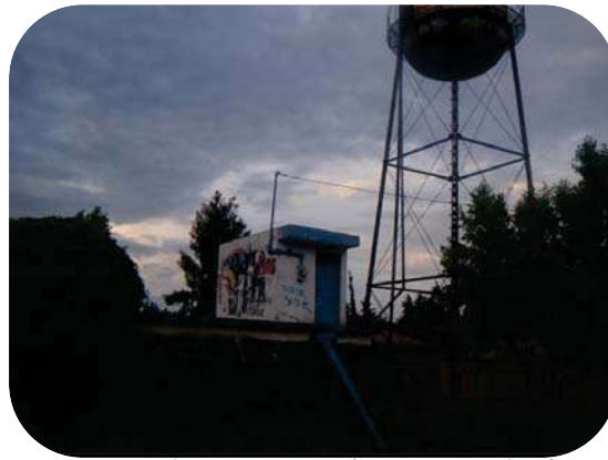
Fig. 40 Pozo de Agua – E. I. Huape V. (18-08-2011 – 18:48 horas).
