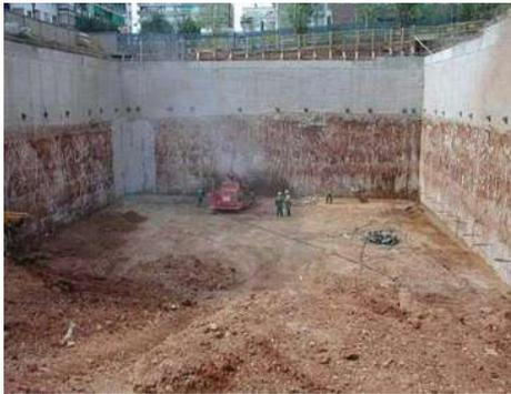
Los muros de contención serán de 50 cm de ancho ejecutados mediante paneles de 2,50 m de ancho y de altura variable en función de la cota del terreno, siendo la altura máxima de 12.5 m (más un metro adicional de viga de coronación), de los que 5,00 m corresponden a la profundidad de empotramiento bajo losa de cimentación.
