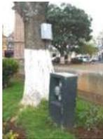
**13.-** Dentro de las jardineras de la plaza se encuentra un *medidor de luz* ubicado a un costado de un árbol, adjunto a este se puede observar un *centro de cargas*, dada su ubicación este deteriora la imagen urbana del área y representa un riesgo para transeúntes al no contar con las protecciones adecuadas. *(Ver fig. 29 para identificación de ubicación del elemento)*
