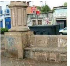
6.- En esta imagen se pueden apreciar las bancas de cantera así como las bases de las columnas de la plaza las cuales presentan manchas, humedad y resalta el grafiti que forma parte de los factores principales causantes del deterioro de la plaza, dando un mal aspecto al lugar. *(Ver fig. 29 para identificación de ubicación del elemento)*
