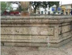
7.- En la imagen se puede apreciar el grado de deterioro de la cantera, a este tipo de daño se le conoce como *escamación periférica*<sup>51</sup> que llega a presentar en algunas ocasiones la cantera. Para esta situación sería conveniente remplazar la pieza dañada. *(Ver fig. 29 para identificación de ubicación del elemento)*
