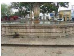
**9.-** En esta imagen se puede observar una de las caras de la fuente en donde se aprecia el efecto de *escamacion periférica*<sup>52</sup> a la derecha, al igual que al centro así como la manifestación de una fuga de agua producto de la concentración de humedad y la falta de mantenimiento del cual ha carecido dicha fuente de cantera a través del tiempo. *(Ver fig. 29 para identificación de ubicación del elemento)*
