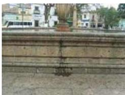
**8.-** En la parte central de uno de los muros de contención de la fuente se puede apreciar una fuga de agua ocasionada por la concentración de humedad y la falta de mantenimiento aumentando el grado de deterioro. *(Ver fig. 29 para identificación de ubicación del elemento)*
