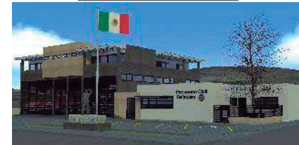
22 de Diciembre 09:00hrs Fachada Sur
