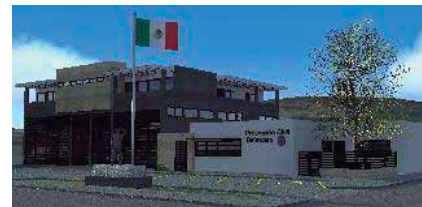
22 de Septiembre 18:00hrs Fachada Sur
