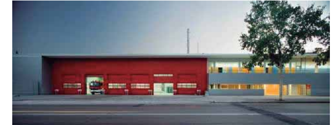
Ilustración 42 Fachada Principal Parque de Bomberos Mataró. Fuente: ( http://es.wikiarquitectura.com , 2011 b).
