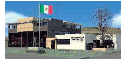
22 de Diciembre 12:00hrs Fachada Sur
