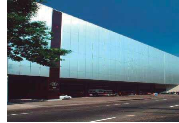
Ilustración 46 Vista Exterior Estación de Bomberos Ave Fénix.
