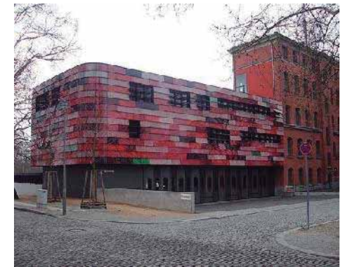
Ilustración 7 Estación de bomberos de Berlín, Alemania. Donde se observa el modo en que se integra al entorno empleando un acabado moderno. Fuente: (Txapulin, 2008)
