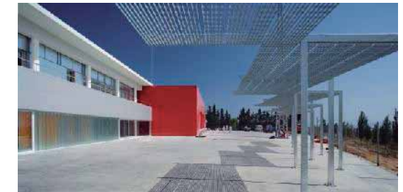
Ilustración 45 Vista Lateral Parque de Bomberos Mataró.
