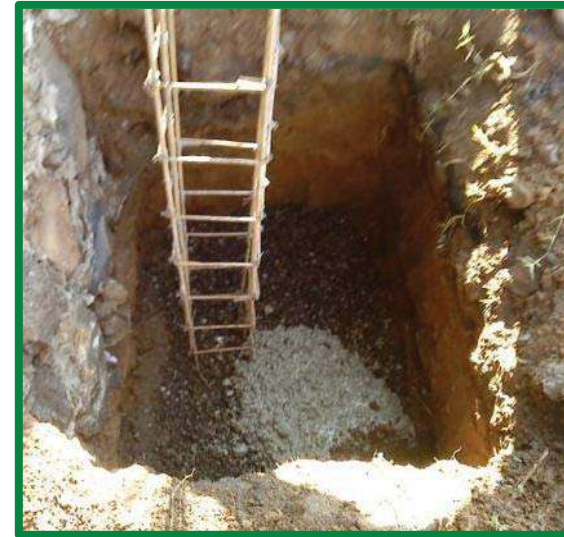
Imagen 90. Fotografía proporcionada por VMMG. Ejemplo de una zapata aislada
