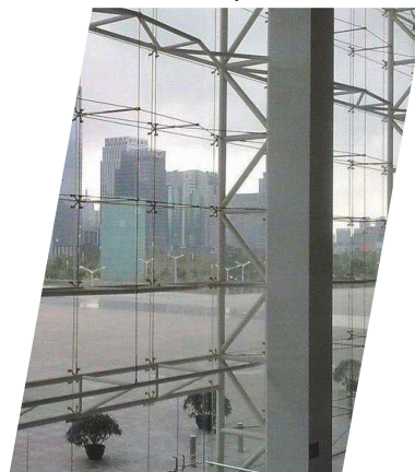
Imagen 34 1 forma de colocar los cristales en los elementos estructurales.
