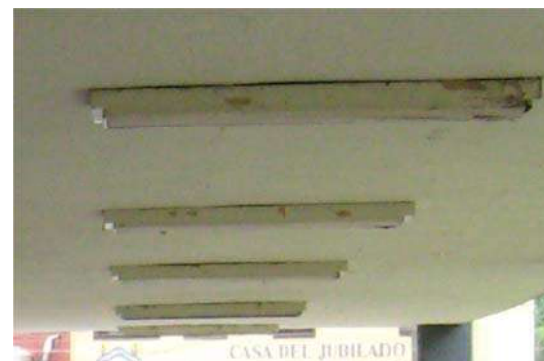
Fotografía 57. Fotografía del pasillo techado dentro de la Ciudad Universitaria Fotografía de Zintly Linares.
