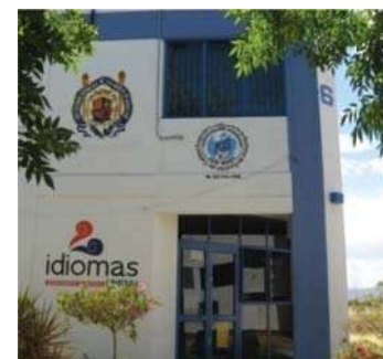
Fotografía 33. Edificio CADI de la Ciudad Universitaria. Fotografía de Zintly Linares.
