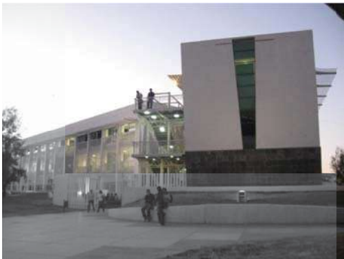
Fotografía 3. Estado actual de edificio N-1 y N-2, fachada moderna de la segunda etapa de construcción de la Ciudad Universitaria. Fotografía de Zintly Linares.
