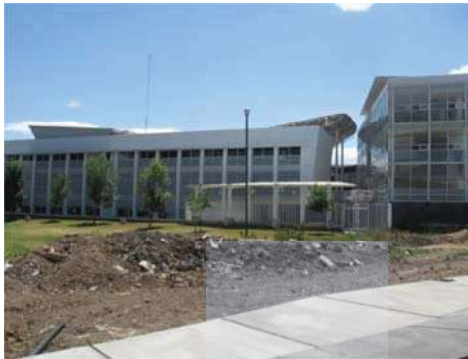
Fotografía 16. Estado actual del edificio de Arquitectura de la Ciudad Universitaria. Fotografía de Zintly Linares.
