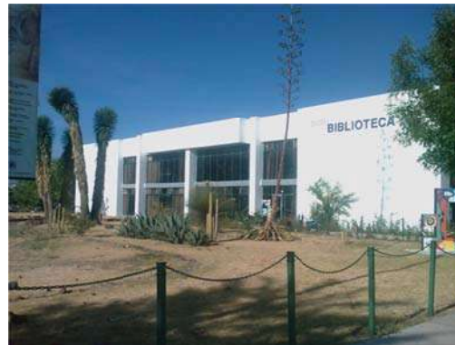
Fotografía 4. Estado actual del edificio S, edificio con fachada moderna de la primera etapa de la Ciudad Universitaria. Fotografía de Zintly Linares.
