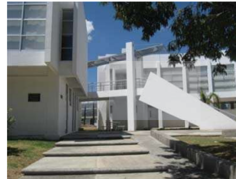
Fotografía 17. Estado Actual del conjunto de edificios de Filosofía de la Ciudad Universitaria. Fotografía de Zintly Linares.
