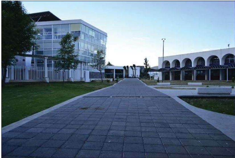
FOTOGRAFÍA DEL ESTADO ACTUAL VIALIDAD SIN TECHAR
