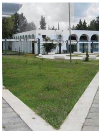
Fotografía 91. Estado actual del jardín 9 localizado en la fachada lateral del nuevo edificio de Arquitectura en la Ciudad Universitaria. Fotografía de Zintly Linares.
