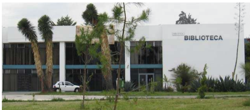
Fotografía 92. Estado actual del jardín 14 localizado en la fachada lateral del edificio M en la Ciudad Universitaria. Fotografía de Zintly Linares.
