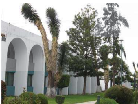
Fotografía 95. Estado actual del jardín 13 localizado en la fachada lateral del edificio P en la Ciudad Universitaria. Fotografía de Zintly Linares.
