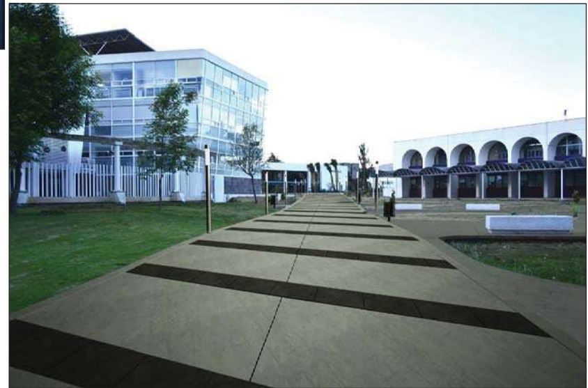
FOTOGRAFÍA DEL MEJORAMIENTO VIALIDAD SIN TECHAR
