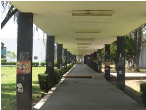
Fotografía 8. Estado actual del pasillo techado de la primera etapa de construcción de la Ciudad Universitaria. Fotografía de Zintly Linares.
