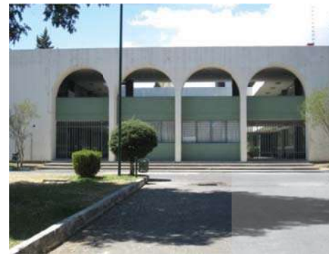
Fotografía 14. Estado actual de edificio L de la Ciudad Universitaria. Fotografía de Zintly Linares
