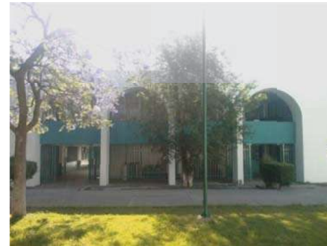
Fotografía 40. Fachada trasera del edificio B obtenido de la Ciudad Universitaria de Morelia Mich., 2007. Fotografía de Zintly Linares.
