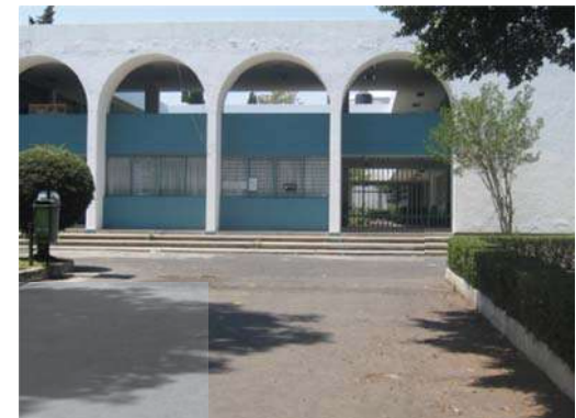
Fotografía 5. Estado actual de edificio L, edificio con fachada arcada de la Ciudad Universitaria. Fotografía de Zintly Linares.
