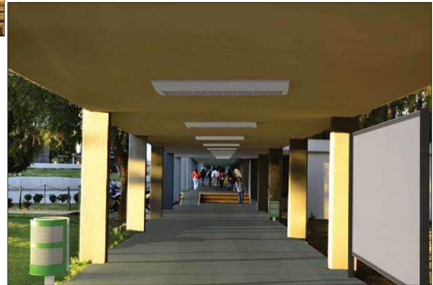
FOTOGRAFÍA DEL MEJORAMIENTO VIALIDAD TECHADA
