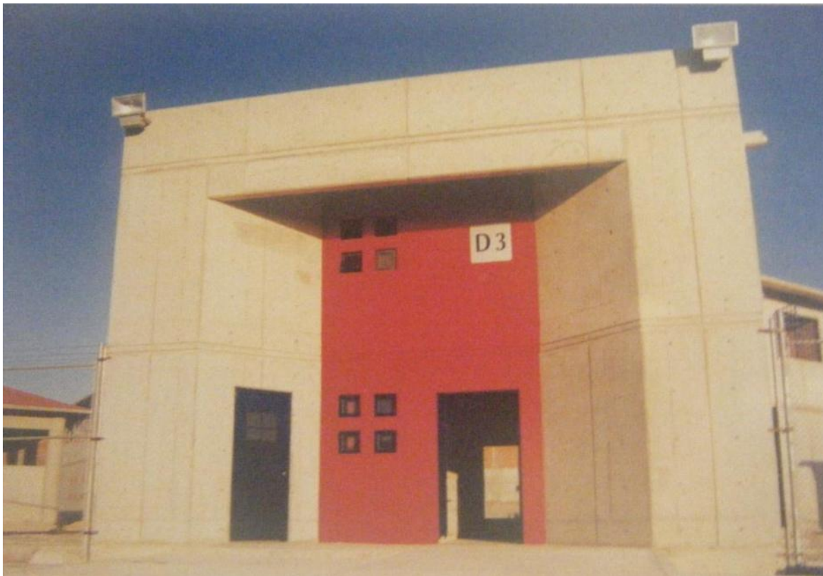
Fig.28.-Centro de Readaptación Social Morelos.
