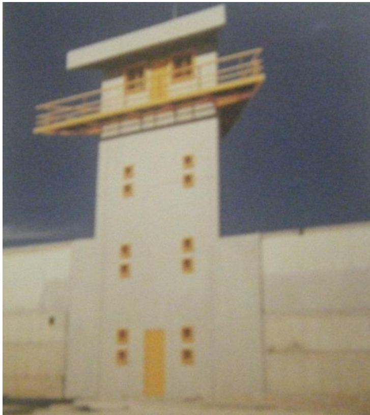
Fig.20.-Torre de vigilancia. Fuente.- Precoor , "Arquitectura Penitenciaria México", en Enlace, año 12 No.5, Mexico,2002,pp.66.
