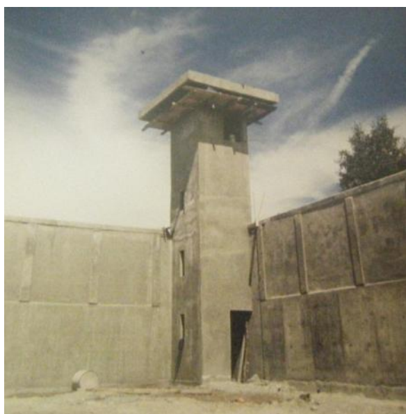
Fig.16.-Torre de vigilancia Fuente.- Precoor , "Arquitectura Penitenciaria México", en Enlace, año 12 No.5, Mexico,2002,pp.60-61
