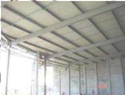
Fig. 53 Forma en que fija la lamina de multitecho en la estructura de acero, Imagen arq.com
