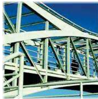
Fig. 56 Estructura de acero de un puente, Imagen arq.com
