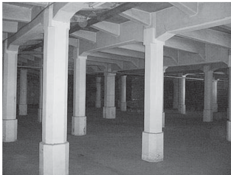
Fig. 52 Estructura de concreto armado, Imagen arq.com
