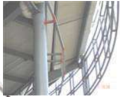
Fig. 52 Forma en que fija la lamina de multitecho en la estructura de acero, Imagen arq.com
