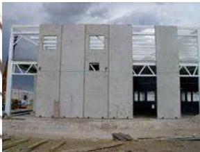
Fig. 44 Colocación de panel de Concreto en estructura de acero, fotografía arq.com
