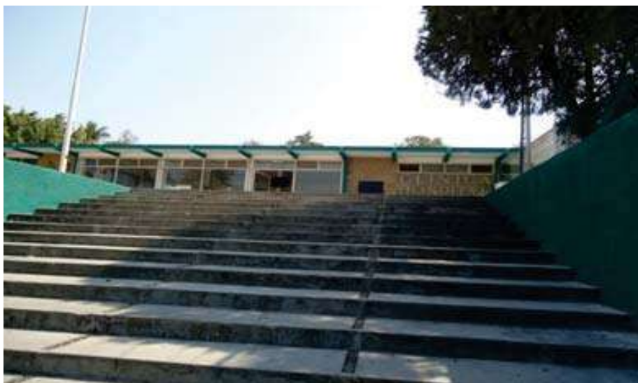
Ilustración 23. Escalinata de acceso. Clínica Puruarán. Foto V.T. tomada por Víctor A. Guillén García.
