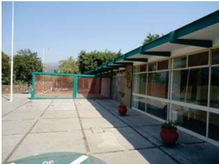
Ilustración 24. Acceso Principal. Se observa el muro acristalado, para integración con el exterior, así como para promover la ganancia lumínica y de ventilación provenientes del exterior. Clínica Puruarán. Foto V.T. tomada por Víctor A. Guillén García.
