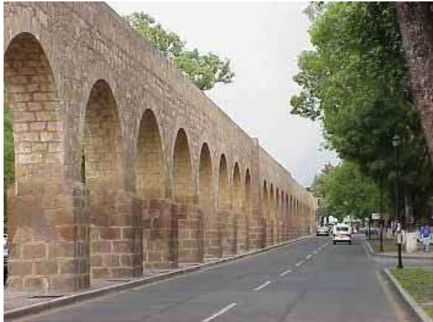
Acueducto IMAGEN No.16
