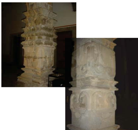
Imagen 2.7.7 Se ilustran en ella los diferentes tipos de columnas existentes en el inmueble 4
