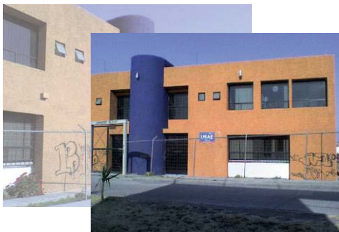
Imagen 4.2.9 En esta ilustración se muestran las oficinas donde se tramitan las becas escolares por parte del Gobierno del estado y se encuentra localizadas en el lado noroeste del predio seleccionado.
