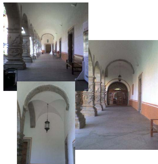
Imagen 2.7.2. Corredores del centro de las artes delimitados por las columnas de tipo neoclásico, con pisos de cantera y bóvedas de medio cañón que en las esquinas se interceptan y quedan en 4 puntos.
