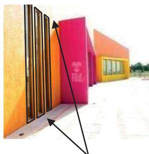
Figura No. 77 fachada lateral con ventanas de piso a techo, y otras de de piso a doble altura.
