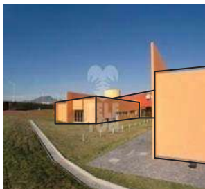
Figura No. 56 Fachada posterior donde se aprecian diferentes alturas en los volúmenes.
