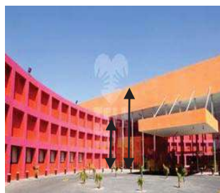
Figura No. 85 Aquí podemos observar el juego de alturas entre los módulos, los consultorios con doble altura y el pasillo principal a doble altura y media para dar un clima fresco al interior con mucha ventilación
