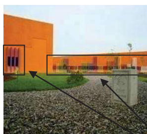
Figura No. 65 Fachada posterior del CRIT, se aprecia el uso del color naranja en todas sus fachadas exteriores.
