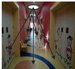
Figura No. 57 Huecos en la losa que proporcionan el paso de luz natural a los pasillos.
