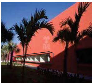
Figura No. 68 El uso de ventanas arremetidas, permite la entrada de luz natural, pero evita el calor dentro del espacio.
