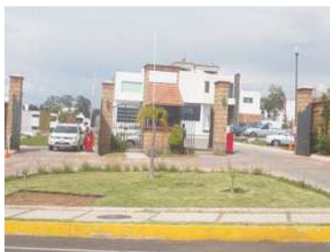
Imagen 39. Acceso a uno de los fraccionamientos en "Altozano".
