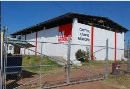
Imagen 19. "Instalaciones actuales del Centro de Control Canino", ubicado en la Av. Álamo. Fotografía L.E.H.M.
