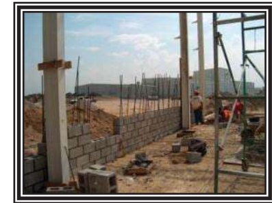
IMAGEN 57, Construcción de muro de block hueco, [http://www.grupojoben.com/concreto/muros_sm/iso_20_small.JPG]
