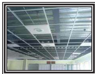
IMAGEN 69, Estructura de plafón colgante, [http://tablarocaguadajajara.com/wp-content/uploads/2011/03/SuspensionesColgantes-300x225.jpg]
