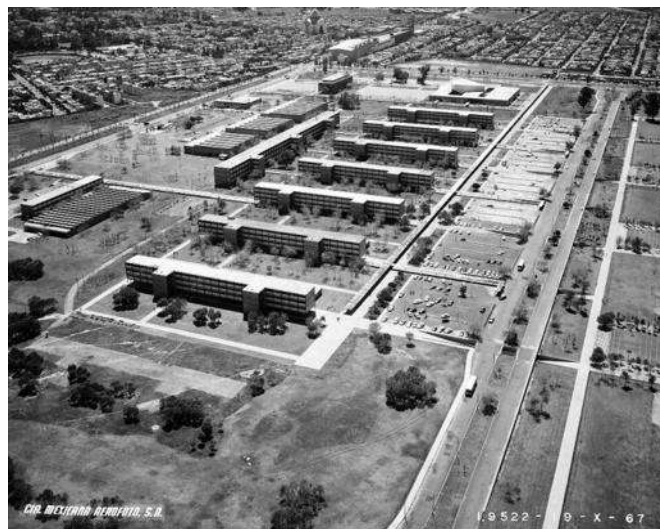
FIG. 12 En la imagen, los edificios del IPN en el plantel de Zacatenco, de estética racionalista, conforme al carácter técnico del plantel. Foto: http://bit.ly/dYGo1g
