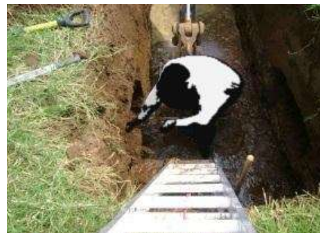
FIG. 44 Extrayendo las muestras del terreno para el correspondiente estudio de mecánica de suelos. Foto: Laboratorio de materiales “Ing. Luis Silva Ruelas”
