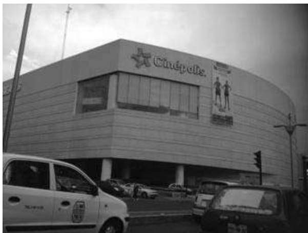
F.70/Fachada Cinépolis América/Fotografía tomada por AARS
