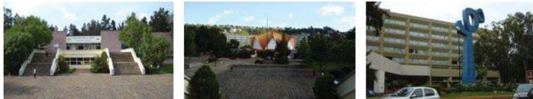
De izquierda a derecha: Biblioteca FJM, Vista aérea del Planetario de Morelia y Fachada Sur de Hotel Fiesta Inn
