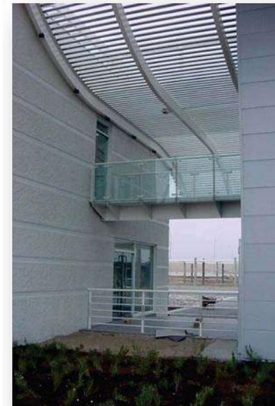
**Fig. A.10.** Cortasoles que regulan la radiación solar.
