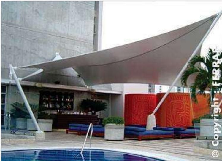
**Fig. E.23.** Membranas tensadas mediante cables de sujeción.
