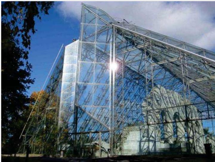
**Fig. E.14.** Perfiles de acero que sujetan los vidrios.
