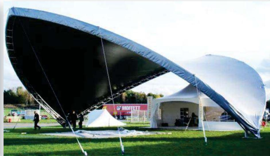
**Fig. E.24.** Membranas tensadas mediante armaduras.
