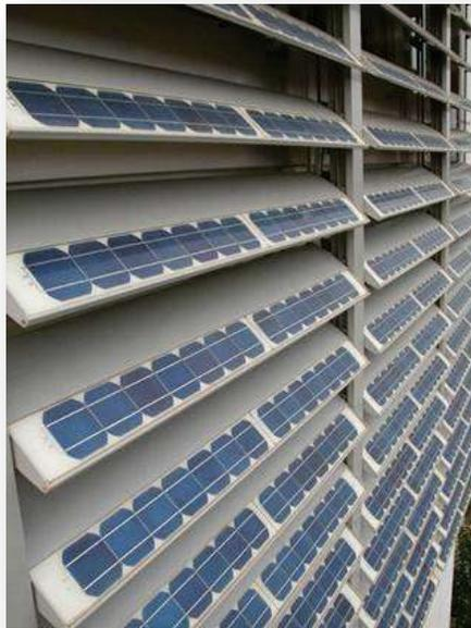
**Fig. A.8.** Persianas automatizadas que permiten regular la radiación solar directa.
