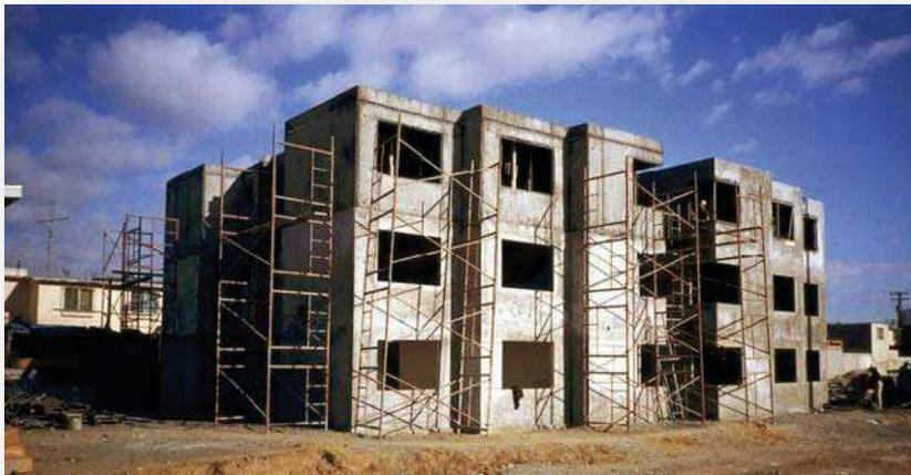
Fig. E.17. Construcciones con panel W.
