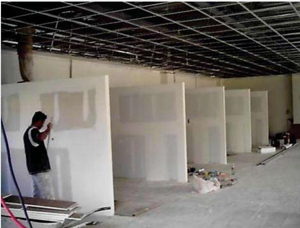
**Fig. E.21.** Fácil modulación de los espacios con la utilización de tableros de yeso.
