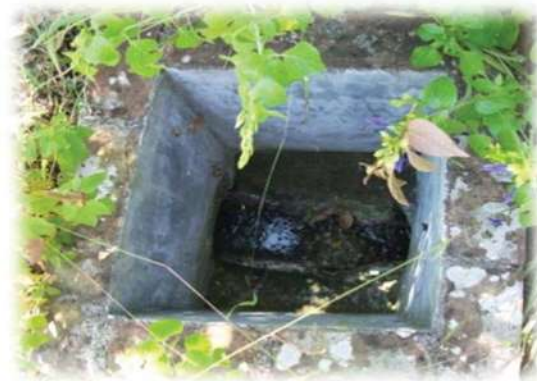
08. Registro de alcantarillado que se encuentra en el terreno. VMGP.
