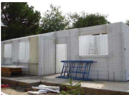
04. Muros divisorios con Panel W. http://www.arghys.com/fotos/wp-content/uploads/2011/04/como-construir-con-panel.jpg
