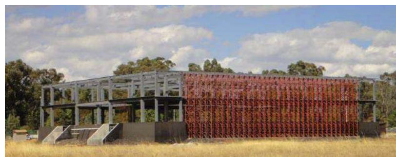
Instalaciones en construcción de Ciudad Universitaria 2011 R.V.R.
