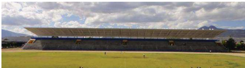
Instalaciones deportivas de la UMSNH campus C.U.
