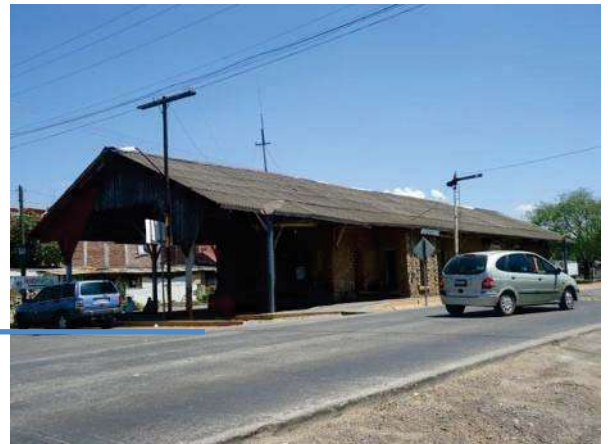
Figura 80.- Antigua Estación de Ferrocarril actualmente Ludoteca Municipal. Foto: Roberto Alvarez. Marzo 2009.
