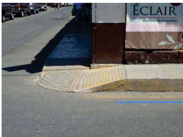
Figura 71.- En la imagen se puede apreciar que en el caso de las banquetas que tienen rampas para discapacitados, las pendientes no son las más adecuadas. Foto: Roberto Alvarez. Febrero 2012.
