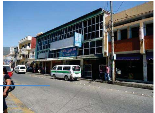
Figura 72.- En la imagen se puede apreciar la base de las combis en la calle Allende Norte. Foto: Roberto Alvarez. Febrero 2012.
