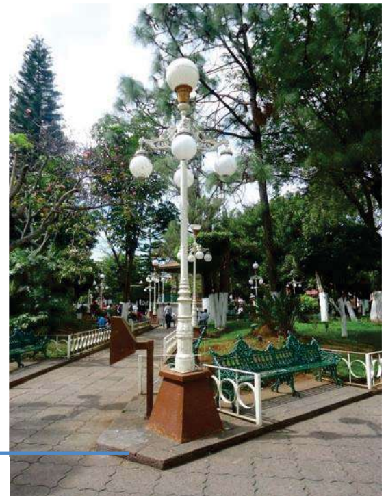
Figura 42.- Las luminarias del centro de la ciudad son de las más antiguas y debido a la falta de mantenimiento algunas no funcionan. Foto: Roberto Alvarez. Febrero 2012.
