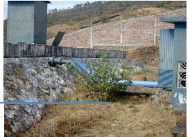
Figura 37.- Toma del depósito de Santa Rosa de donde se distribuye a diferentes partes de la ciudad. Foto: Roberto Alvarez Enero 2012.
