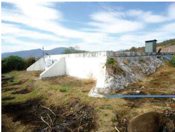
Figura 35.- En Deposito en Santa Rosa, es uno de los más grandes, cuenta con capacidad de 1 000 000 litros, se encuentra en una de las partes más elevadas y por medio de gravedad se distribuye a la red de agua potable. Foto: Roberto Alvarez.. Febrero 2012.
