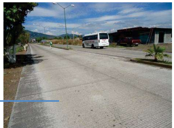
Figura 69.- Carretera a San Sebastián con recubrimiento de Concreto Hidráulico. Foto: Roberto Alvarez. Noviembre 2011.
