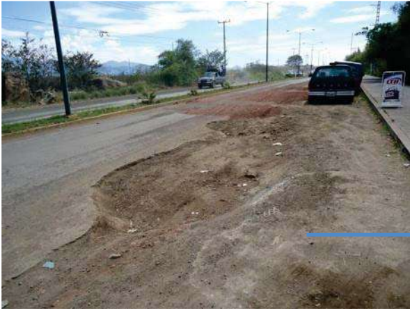
Figura 45.- El estado en el que se encuentran algunas calles y avenidas importantes es deplorable, tal es el caso de la avenida a San Sebastián. Foto: Roberto Alvarez. Enero 2012.
