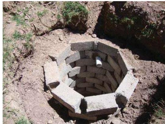
**IMAGEN\_141** Pozo de absorción hecho con muros de tabicón sobre terreno natural.
