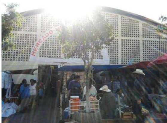
Fig. 4. Fachada principal del Mercado Municipal.
