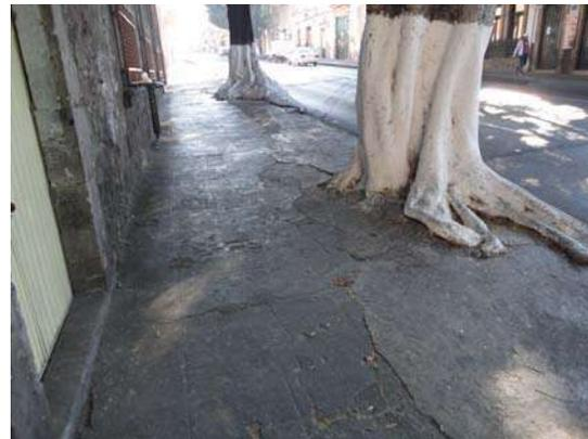
**Imagen 41** Estado actual de las aceras y afectaciones de los árboles causan al no existir alcorques ni arriates y a la agresividad natural de las raíces del Laurel de la India.
