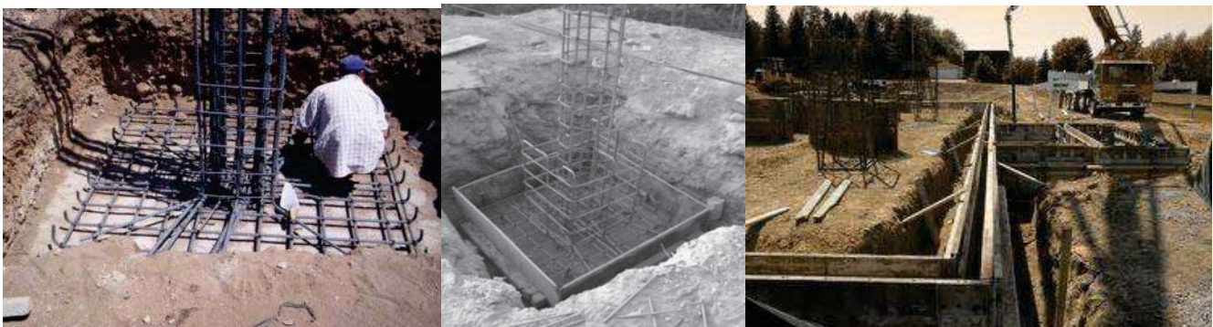
Gráfico No.1,2,3/ Zapata aislada 1-2, zapata corrida /
