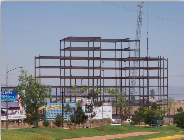
Fig. 3.4 Hospital Abor (en construcción). Fuente: Autor
