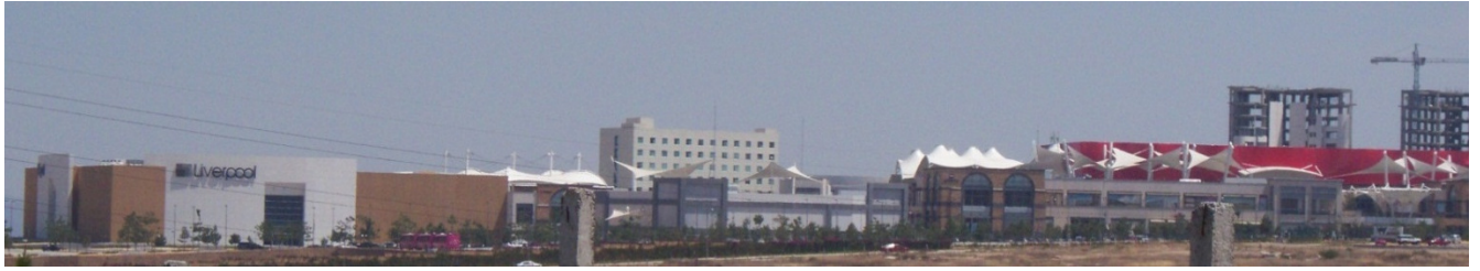
Fig. 3.3 Centro Comercial Altozano. Fuente: Autor
