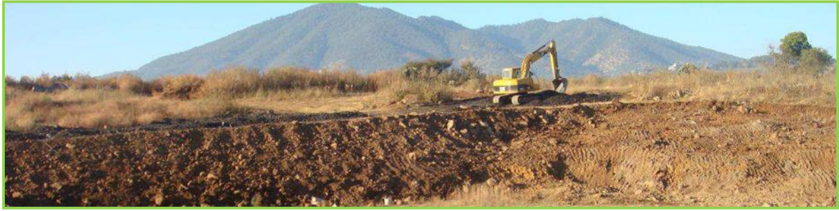
Imagen 32. Muestra de la realización los niveles de subrasante por medios mecánicos FUENTE: Omar Marcos Sánchez 98
