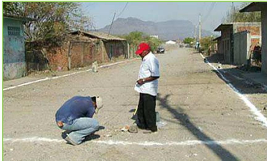
Imagen 31. Ejemplo del trazo de un polígono en campo por medio de estacas FUENTE: Omar Marcos Sánchez 97
