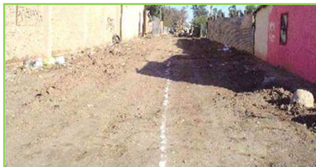
Imagen 34. Muestra de los trabajos preliminares antes de la colocación del alcantarillado FUENTE: Omar Marcos Sánchez 100
