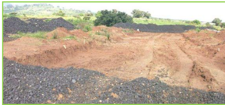
Imagen 33. Muestra de los trabajos preliminares antes de la colocación del alcantarillado FUENTE: Omar Marcos Sánchez 99
