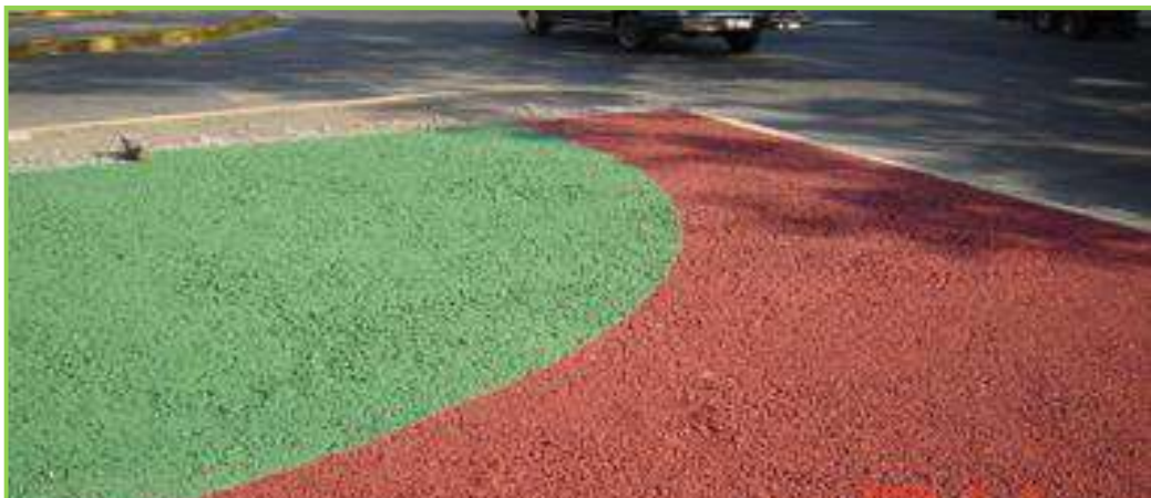
Imagen 41. Franjas laterales de calles, hechas con Ecoconcreto FUENTE: Adieco Sostenible 109
