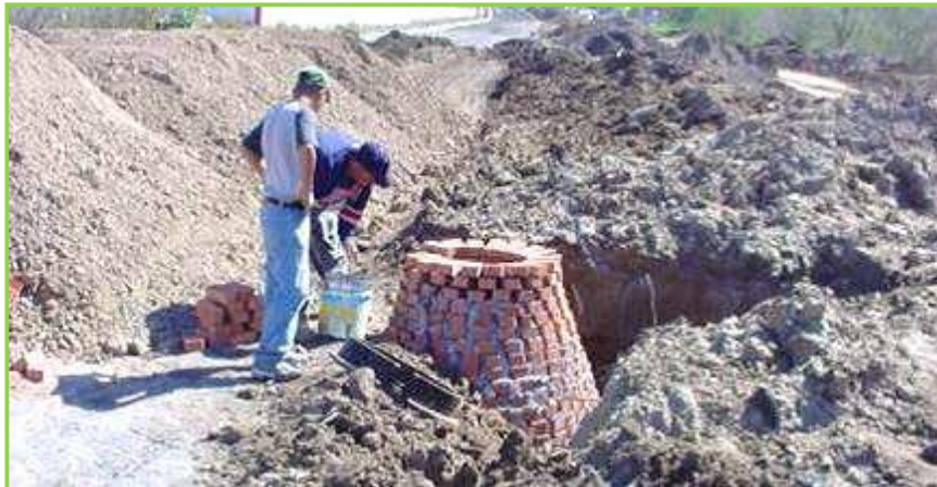
Imagen 35. Realización de los Pozos de Visita para el sistema de alcantarillado FUENTE: Omar Marcos Sánchez 101
