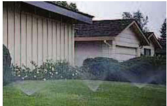
Imagen N°38(sistema de riego)
