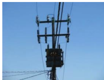
Foto N°73 transformador
