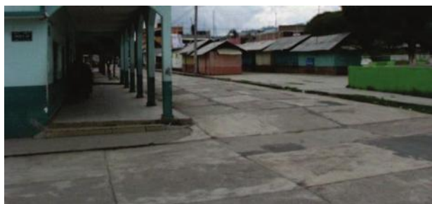
Imagen N°78 pavimento concreto simple calles circundantes a la plaza
