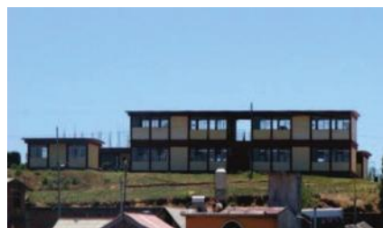
Imagen N°43 escuela secundaria Gómez Farías
