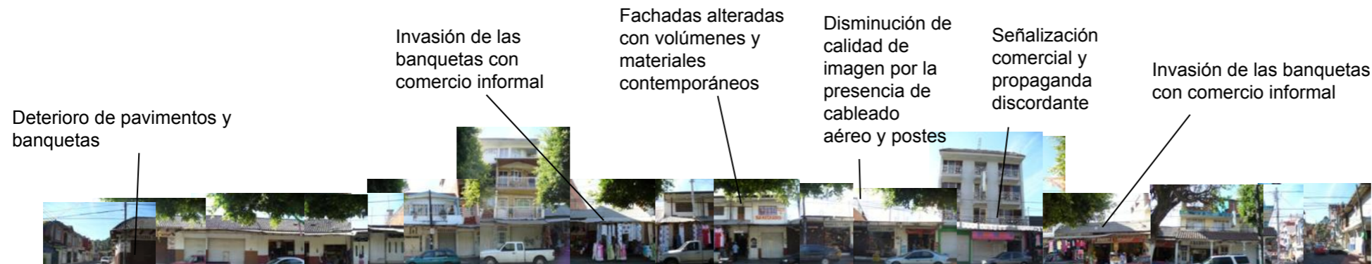
Estado actual de la zona a intervenir Av. Lázaro Cárdenas
