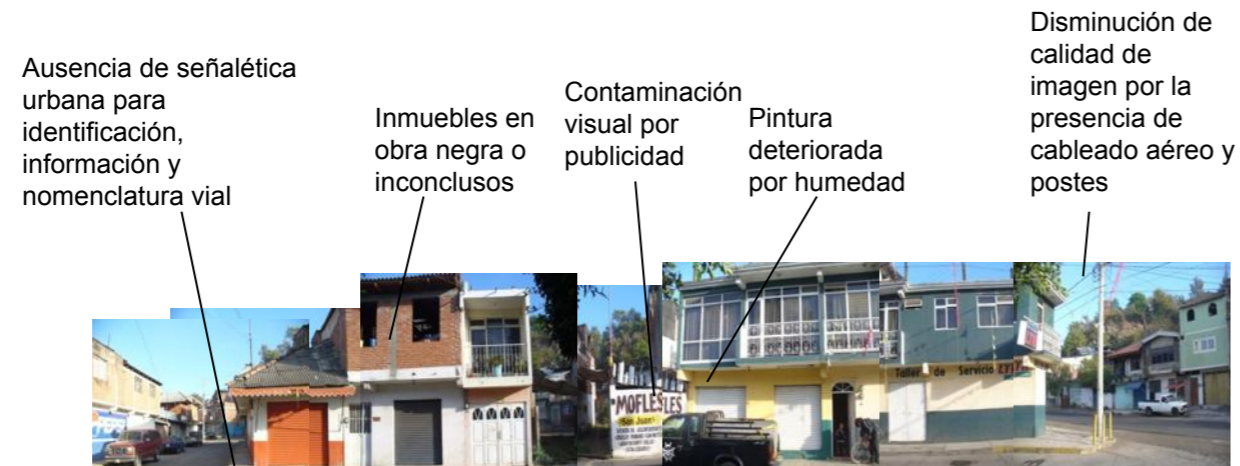
Estado actual de la zona a intervenir Av. Lázaro Cárdenas
