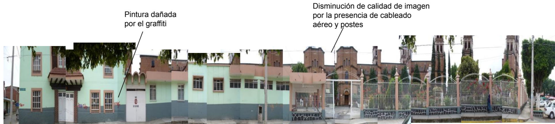
Estado actual de la zona a intervenir Av. 20 de Noviembre
