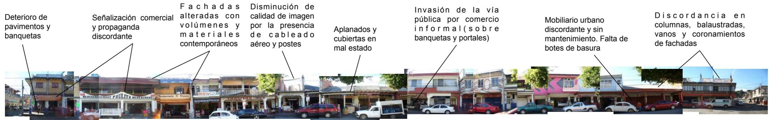
Estado actual de la zona a intervenir Portal Melchor Ocampo, Av. Lázaro Cárdenas
