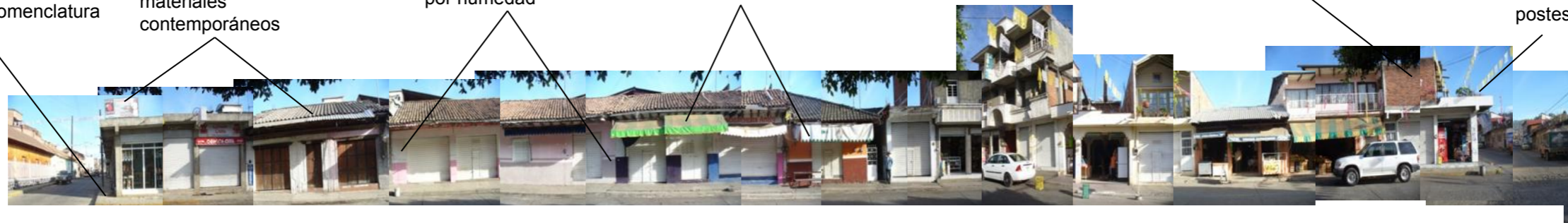
Estado actual de la zona a intervenir Av. Lázaro Cárdenas
