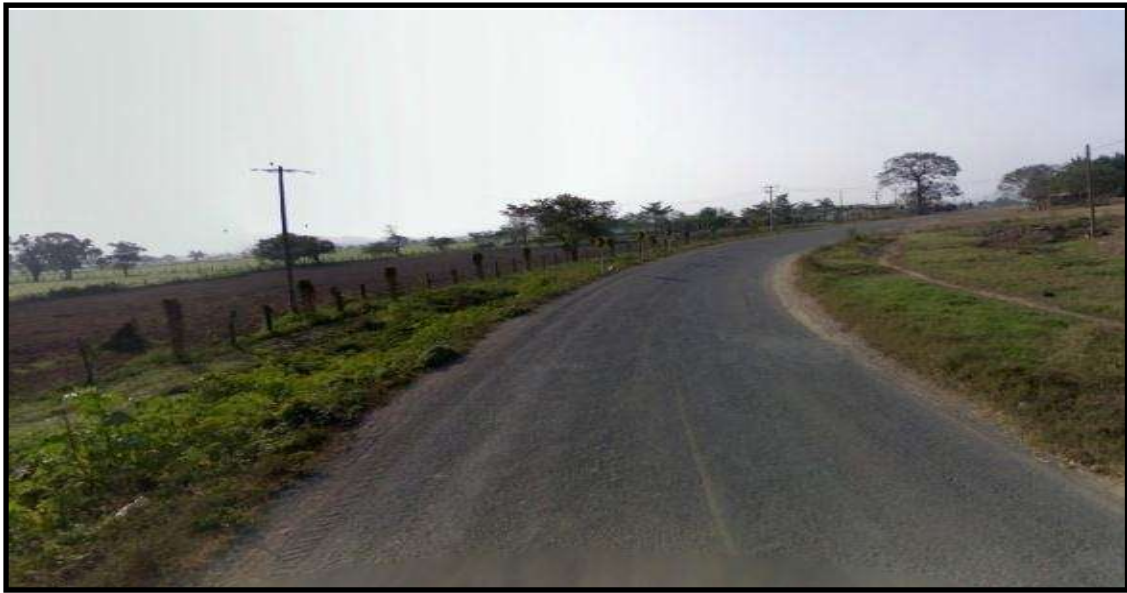
Fig. 71. Carretera que une pasa por un lado del terreno de la terminal aeroportuaria del Aeropuerto Internacional de la Riviera Nayarit y la localidad de Compostela. 97
