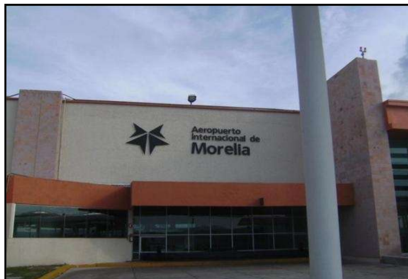
Fig. 10. Fachada de Terminal del Aeropuerto de Morelia. 30
