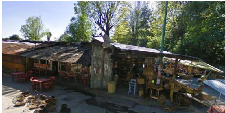
Foto No 9. Obstrucción de área peatonal y vialidad primaria.
