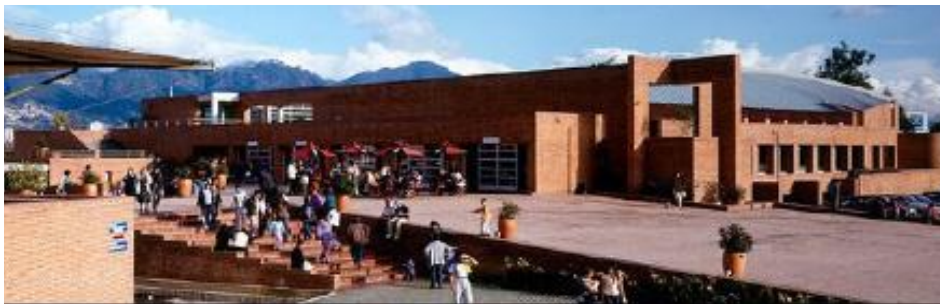
Foto No 93. Acceso principal a la plaza de artesanos. Bogotá, Colombia.
