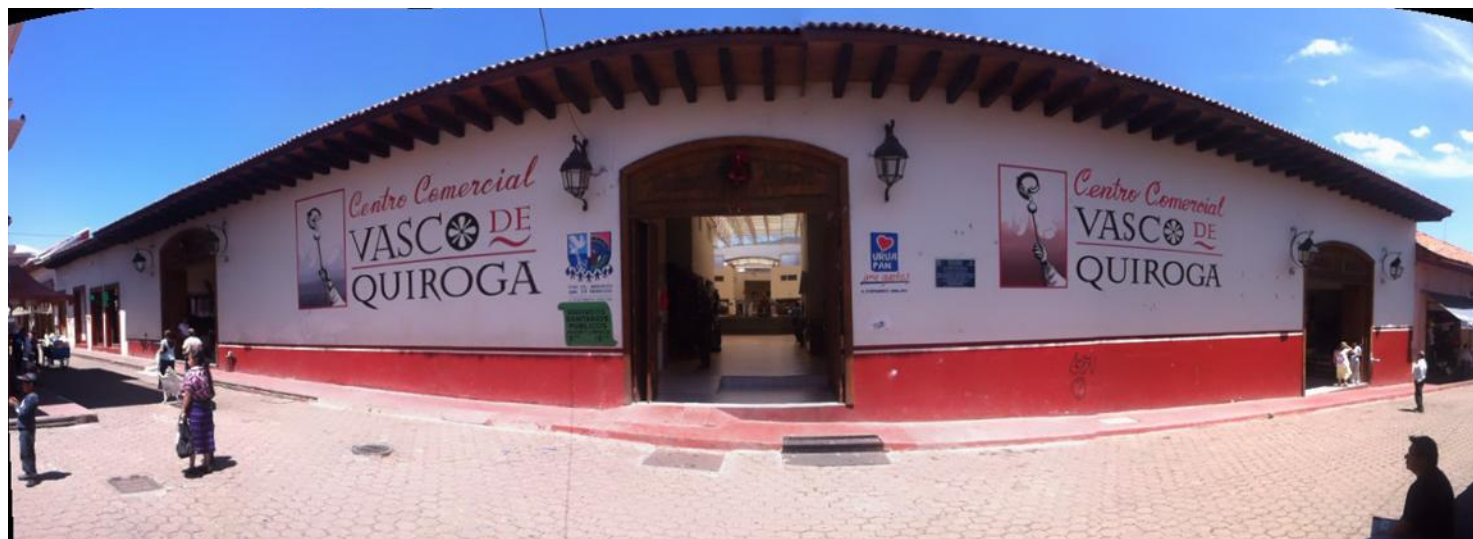
Foto No 98. Fachada principal, donde nos muestra los accesos principales de la plaza.
