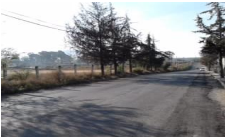
Fig. 32. Vista del terreno y su vialidad.
