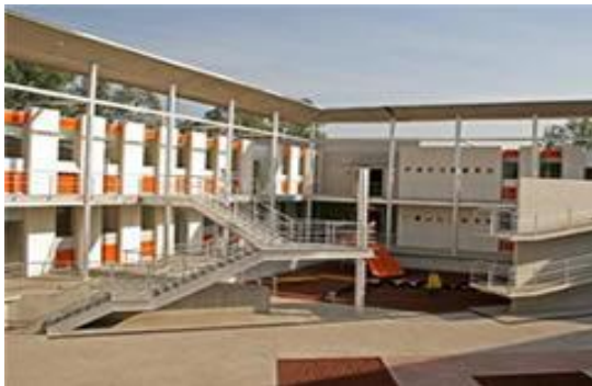
Fig. 12. Patio y escaleras del. Centro Comunitario. Xochimilco D.F. http://www.cnnexpansion.com/obras/2009/06/08la-ruptura-del-paradigma
