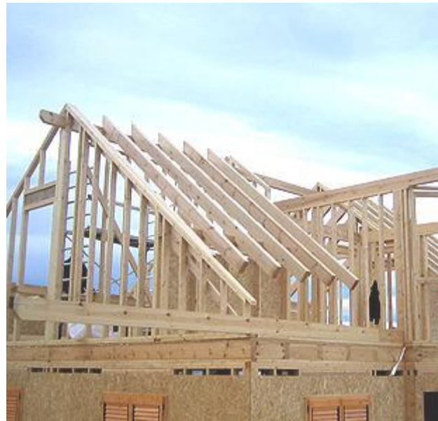
Foto 89, Construcción de Cabaña.
