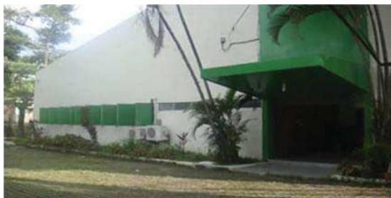
FOTO. 6. Fachada de las Oficinas de FIBERTEX
