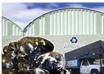
FOTO. 4. Fachada principal de RETAZOTEX Fuente: www.retazotex.com.mx
