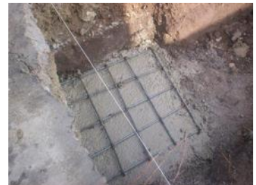
Foto 19._ Esta es una ejemplo de el concreto armado, primero se coloca una plantilla de concreto, despues la varilla en un emparillado colocando las varillas a cada 15cm@ (variable) en mabos lados y despues viene la zapata de 15cm (variable) Foto tomada por D.O.L
