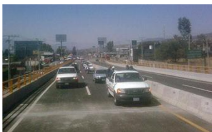
Foto 2. Infraestructura de Transporte: (Puente Terrestre). Imagen tomada por D.O.L
