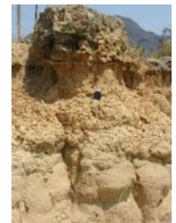
Imagen 7._ El tepetate es usado para mejorar el suelo en caso de que exista un terreno arcilloso. O para rellenar cepas de la cimentacion, tambienes usado para dar pendiente en las losas de azotea.
