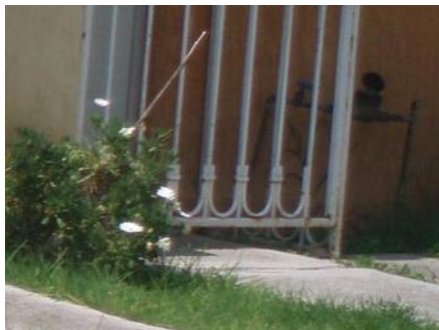
Foto 6._ Infraestructura Hidraulica. (Redes De Agua Potable) El servicio se encuentra funcionando. Es necesario contar con fuentes de agua potable, para lavar, para regar, para servicios sanitarios, aseo, etc. Imagen tomada por D.O.L
