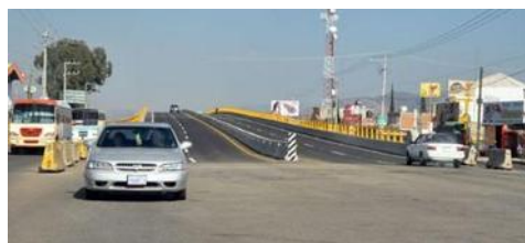
Foto 3. Infraestructura de Transporte: (Carretera). La carretera cuenta con 4 carriles centrales y 4 laterales en ambos lados. En la Desviación a Coitizio se disminuyen los carriles quedando solo 4 centrales. Imagen tomada por D.O.L
