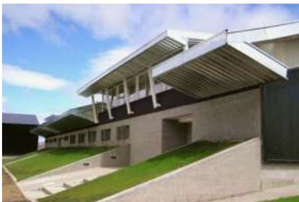
Imagen 18 Vista lateral de la nave, fuente: http://blog.bellostes.com/?tag=naves-industriales
