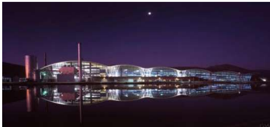
Imagen 32 Iluminación de fachada. Fuente http://www.plataformaarquitectura.cl/2007/10/18/planta-cristalchile-guillermo-hevia/
