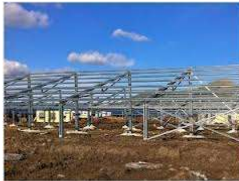
Imagen 56 Vigas de acero. Fuente: http://www.google.com.mx/imgres?imgurl
