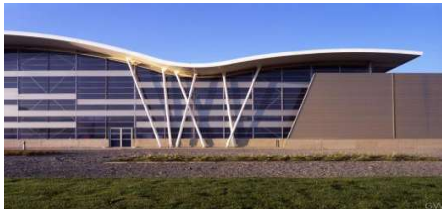
Imagen 31 Cubierta. Fuente http://www.plataformaarquitectura.cl/2007/10/18/planta-cristalchile-guillermo-hevia/
