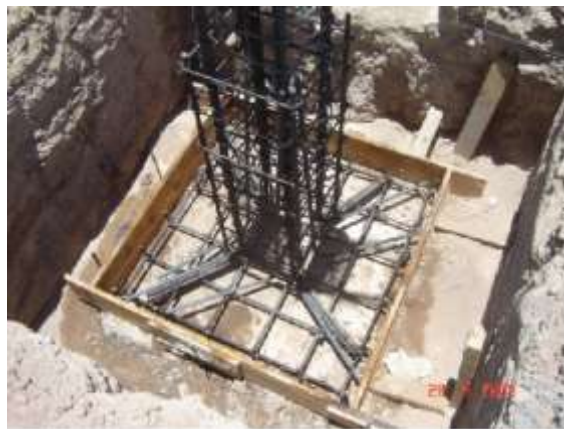
Imagen 54 Zapata aislada. Fuente: http://www.google.com.mx/imgres?imgurl=
