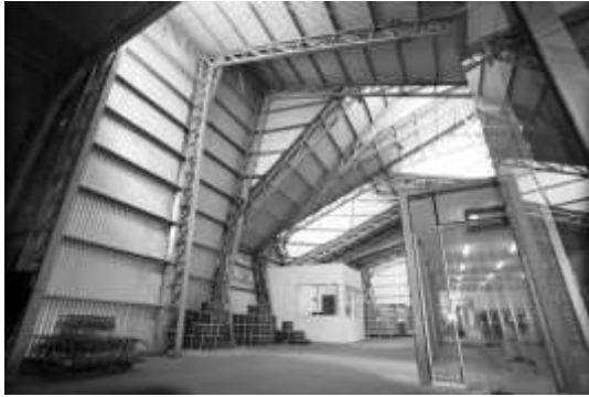
Imagen 11. Interior de la nave de proceso. Fuente http://blog.bellostes.com/?tag=naves-industriales
