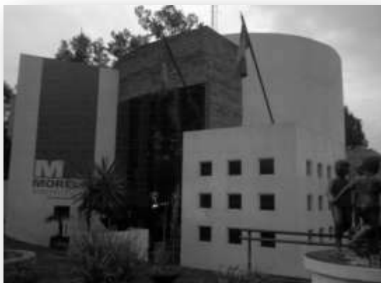
Fig.60- Edificio del DIF Infantil Morelia (Ana Garduño)
