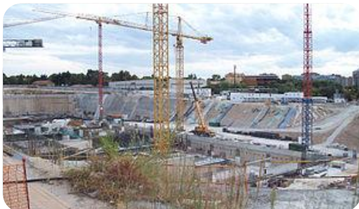
Imagen 1 Centro Internacional de Convenciones de la Ciudad de Madrid
