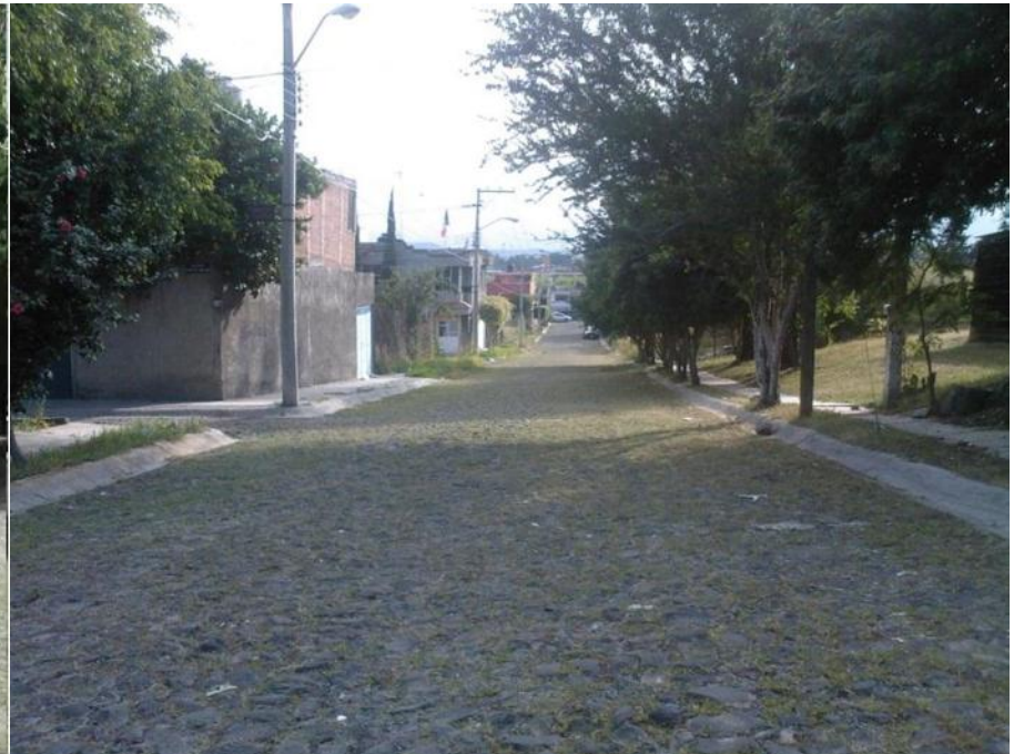
Figura 5.49. Calle Tipitaro Norte a Sur. (Foto 2).
