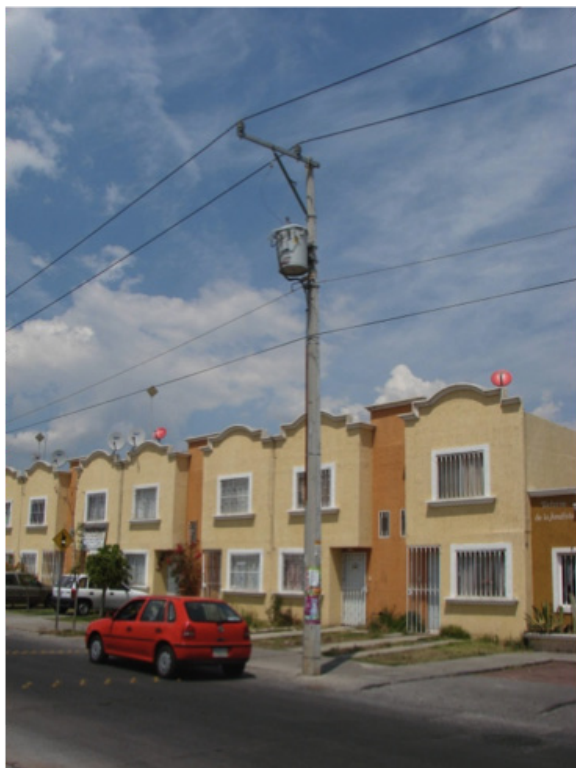
Imágen 16: Poste de servicio eléctrico, CFE. Foto tomada por los autores, 12 de Mayo del 2012
