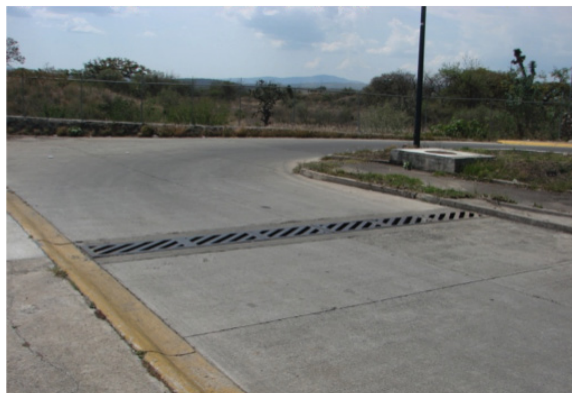
Imágen 14: Alcantarilla de drenaje pluvial. Foto tomada por los autores, 12 de Mayo del 2012
