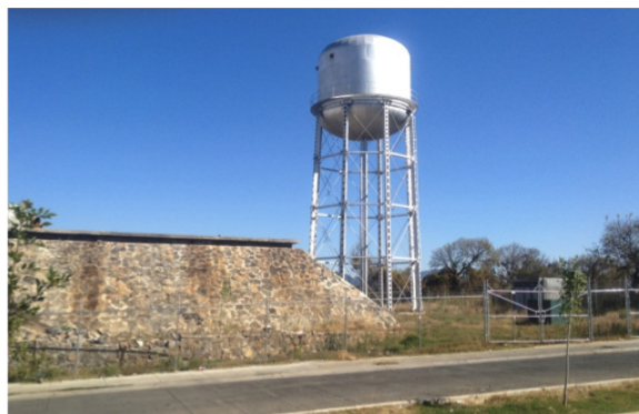
Imágen 13: Tanque elevado del conjunto habitacional “Villas del Pedregal. Foto tomada por los autores, 12 de Mayo del 2012
