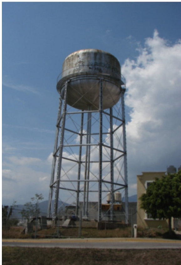
Imágen 12: Tanque elevado del conjunto habitacional “Villas del Pedregal. Foto tomada por los autores, 12 de Mayo del 2012
