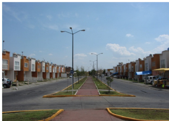
Imágen 19: Postes de alumbrado público, CFE. Foto tomada por los autores, 12 de Mayo del 2012
