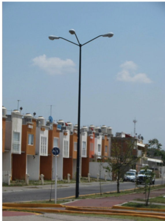
Imágen 18: Poste de alumbrado público, CFE. Foto tomada por los autores, 12 de Mayo del 2012
