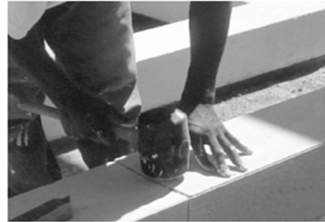
Imagen 47/fijación de block contec /Manual Técnico Contec Mexicana 3ra. Edición/ 2010
