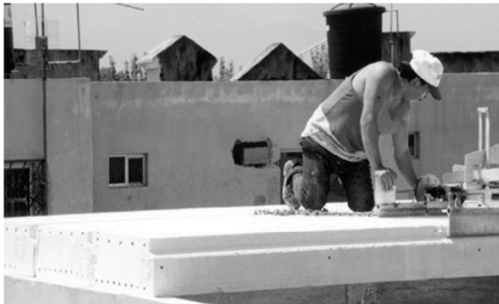
Imagen 64/ajustes de paneles de losa / Manual Técnico Contec Mexicana 3ra. Edición/ 2010
