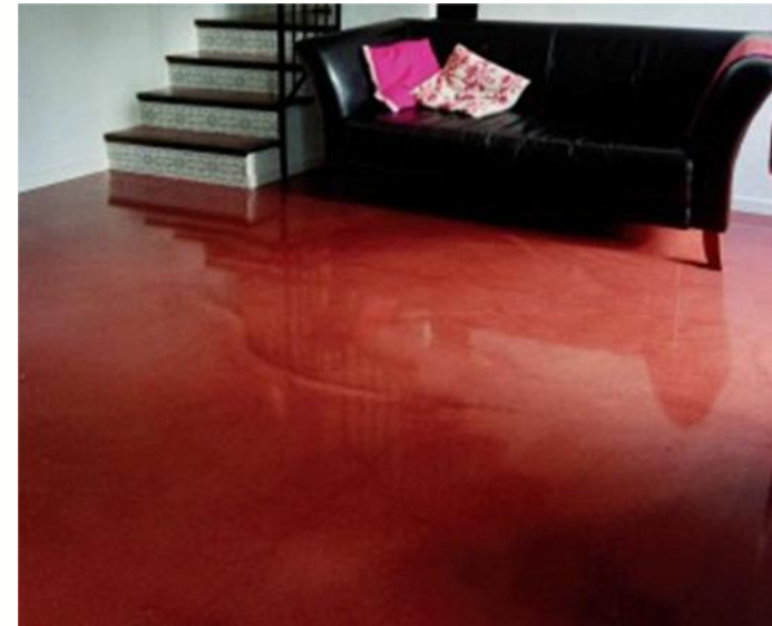
Imagen 68/ concreto autonivelante pulido/ http://www.ddecoracion.com/wp-content/uploads/fllor-1.jpg / 2009
