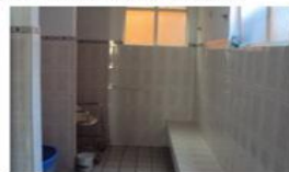
foto. 5 tres baños nuevos con regadera
