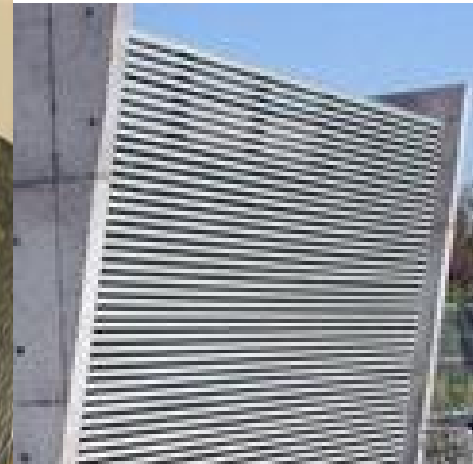
Imagen 12: protección de ventanas
