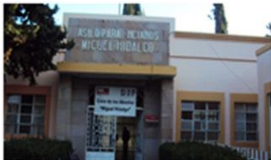
Foto 6: acceso del asilo Miguel Hidalgo
