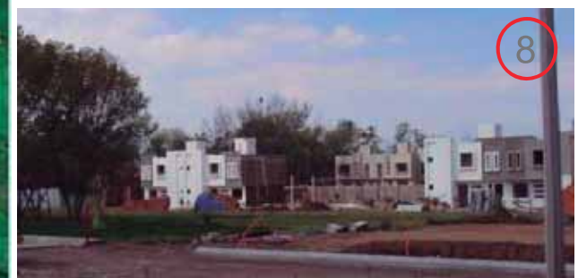
Figura 37. Viviendas en construcción en "Paseo los Encinos" Foto: Autores de tesis
