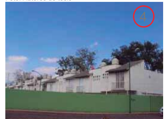
Figura 32. Fachadas de vivienda ofertada en "Real San Diego". Foto: Autores de tesis
