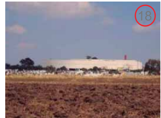
Figura 51. Centro Comercial “Costco” Foto: Autores de tesis
