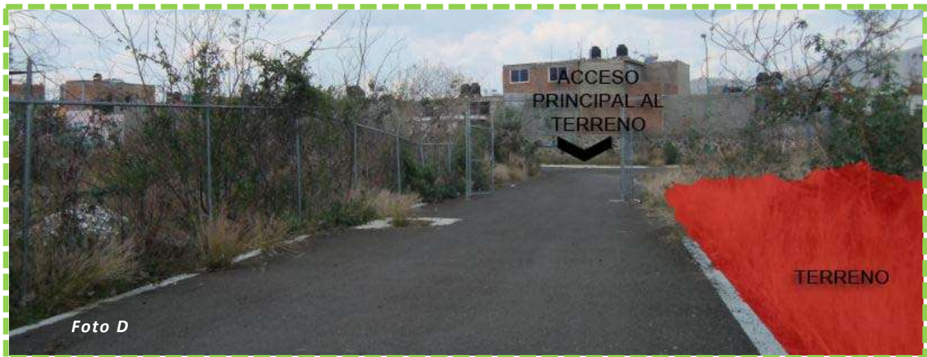
Foto. 54 Acceso principal al terreno, Vista de calle y colinancia, Fuente: Elaboración propia
