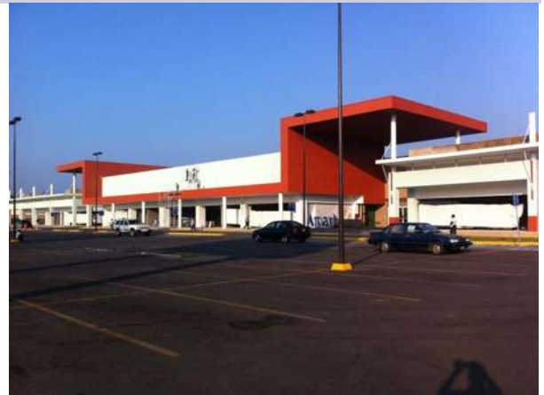
Fig. 1.5.3.9 Aplicación de pintura.
