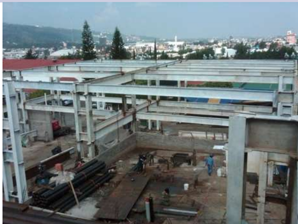
Fig. 1.5.2.6 Estructura metálica, Vigas principales y secundarias.
