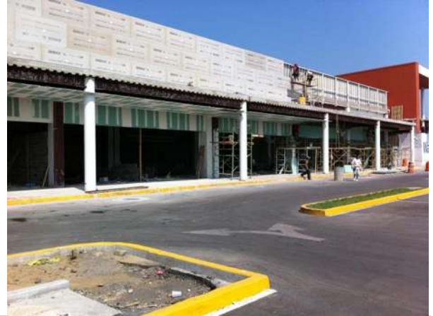
Fig. 1.5.3.7 colocación de paneles de durock sobre estructura metálica.
