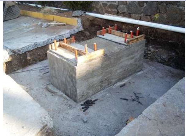
Fig. 1.5.2.5 Cimentación (Zapatas Dadas).
