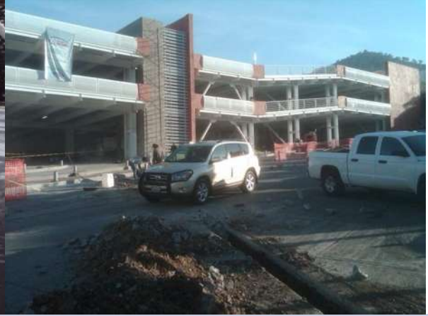
Fig. 1.5.2.9 Vista exterior del edificio.
