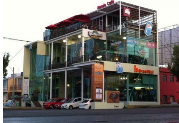
Fig. 1.5.1.7 Vista de la obra en la actualidad.
