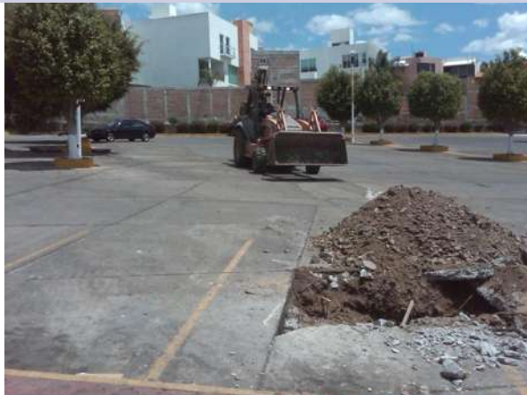
Fig. 1.5.2.4 Sitio de la Obra en su Inicio.
