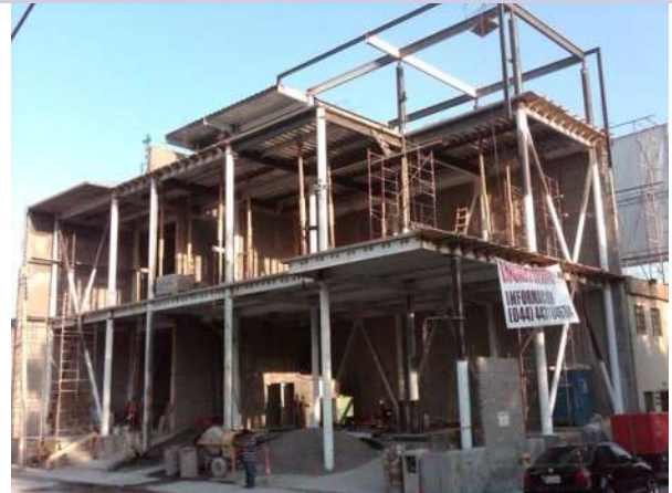
Fig. 1.5.1.5 Vista de la Obra. Preparación de losas.
