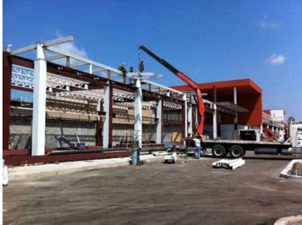
Fig. 1.5.3.6 Montaje de estructura metálica.
