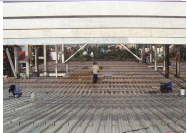
Fig. 1.5.2.7 Colocación de malla electrosoldada. Nervaduras principales y secundarias.
