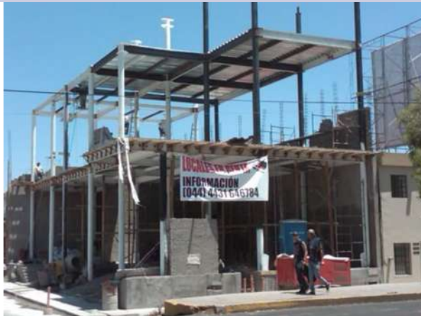
Fig. 1.5.1.4 Vista de la obra. Proceso de estructura metálica.
