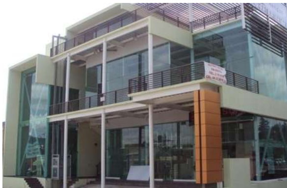
Fig. 1.5.1.6 Vista de la obra al momento de la entrega-recepción.
