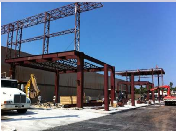
Fig. 1.5.3.4 Montaje de la estructura metálica.
