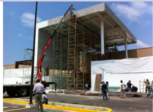
Fig. 1.5.3.5 Colocación de paneles de durrock sobre la estructura metálica.
