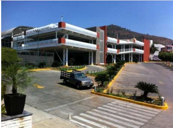
Fig. 1.5.2.10 Vista exterior del edificio al momento de la entrega recepción.
