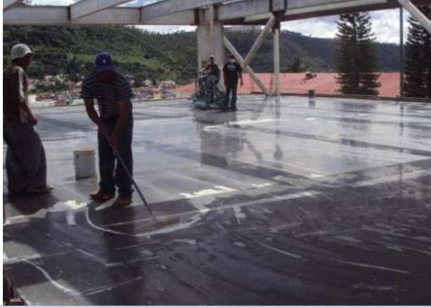
Fig. 1.5.2.8 Curado de losas de concreto reforzado.
