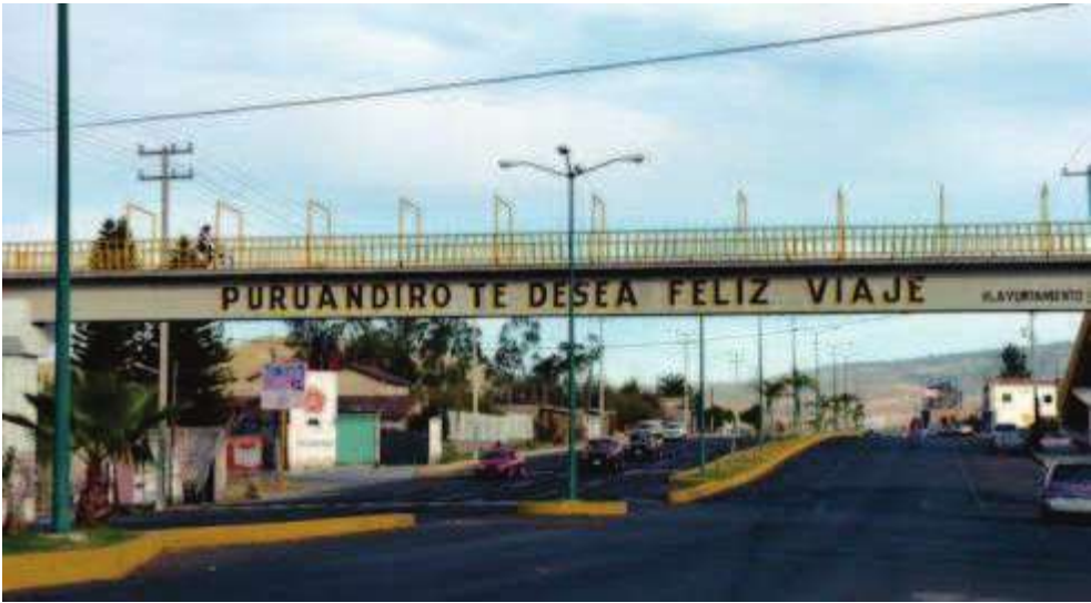
Ilustración 6 | Construcción del Boulevard de la ciudad. Imagen del autor.
