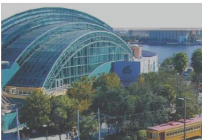
Ilustración37. La cubierta fue diseñada para parecerse a una concha marina. Fuente: http://www.google.com.mx/imgres?
