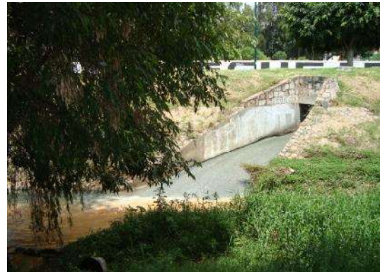
Figura 26. Drenajes que desembocan en el cauce del río Chiquito
