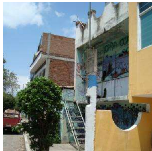
Figura 49. Tipología de vivienda en el tramo 3 ámbito noreste, el nivel de las viviendas queda más bajo que la vialidad que se construyó posteriormente.
