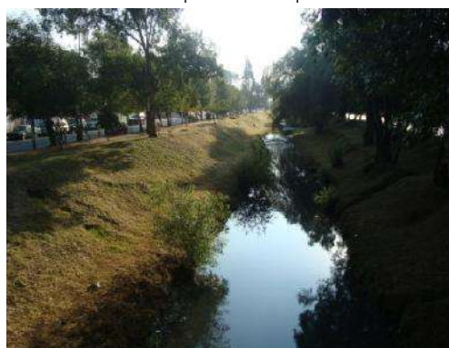
Figura 79. Margen con terreno libre adicional al de la vialidad y del cauce del río en el tramo 1.
