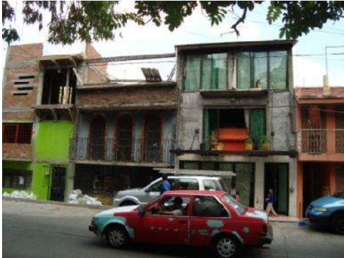
Figura 43. Tipología de vivienda en el tramo 2 ámbito centro, viviendas viejas deterioradas de dos niveles.
