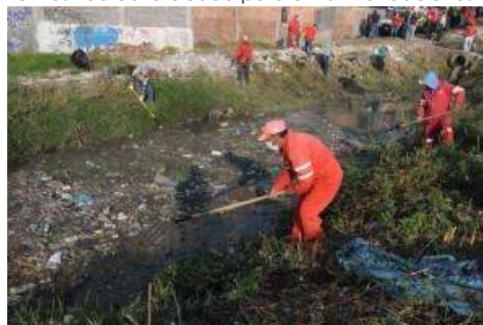
Figura 25. Labores de limpieza en los ríos Grande y Chiquito de la ciudad de Morelia por brigadas de las dependencias de Parques y Jardines así como personal de Aseo Público del Municipio.
