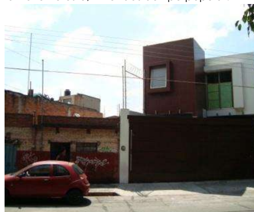
Figura 48. Tipología de vivienda en el tramo 3 ámbito noreste, contraste de viviendas nuevas con viviendas deterioradas
