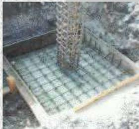
Fig. 70. Zapata aislada.
